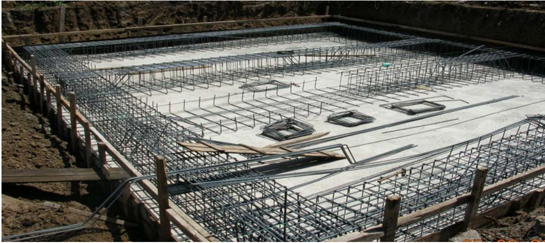
Resim 2.1: Radye jenaral temel (üstten çekilmiştir)
