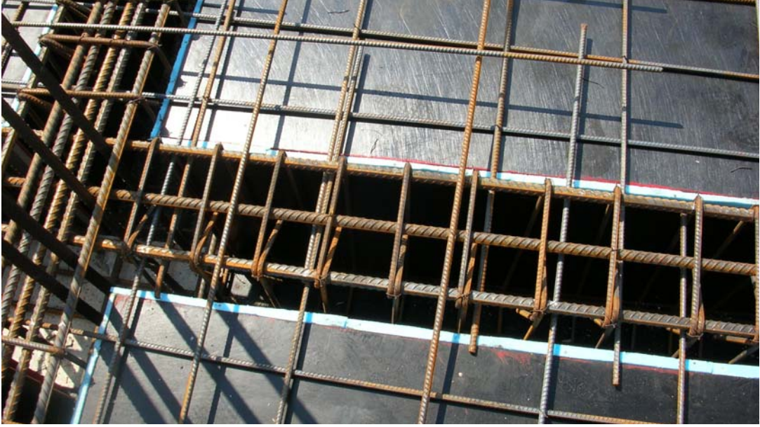
Resim 1.4: Döşeme ile birlikte çalıştırılan tablalı kiriş (üstten bakılarak çekilmiştir.)
