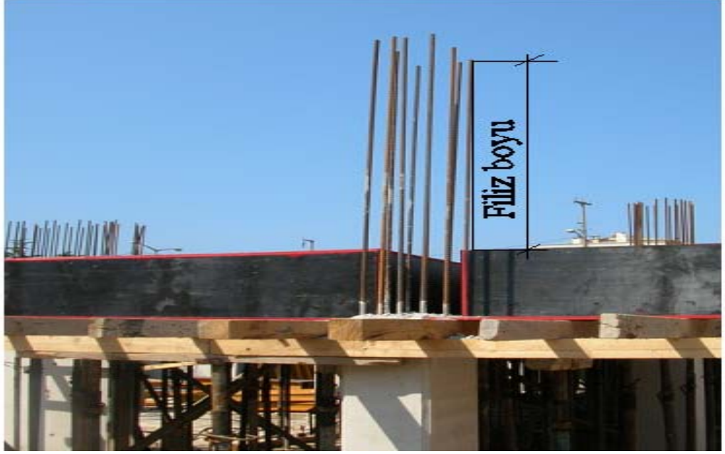
Resim 1.2.2.1: Etriyeli kolon donatı elemanları
